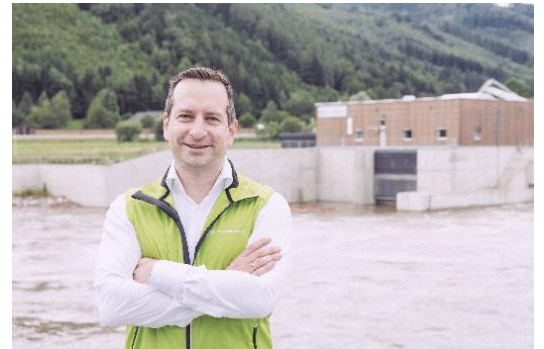
Geschäftsführer Philipp Rehulka vor dem Kleinwasserkraftwerk in Frohnleiten (Foto: MeinAlpenStrom)
